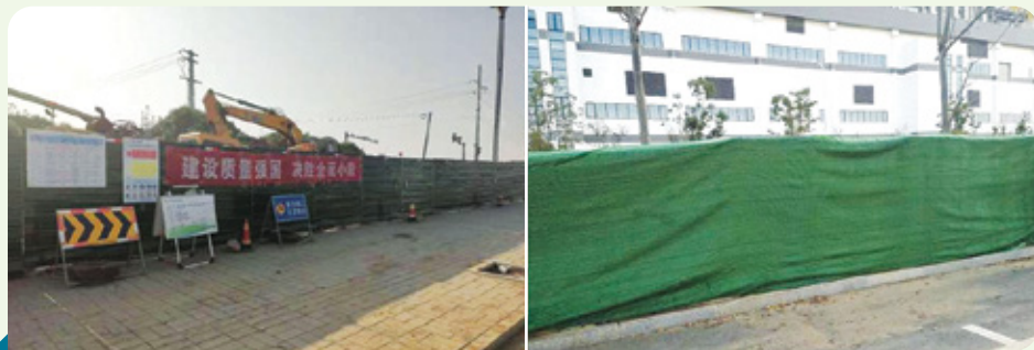
施工現場圖片
