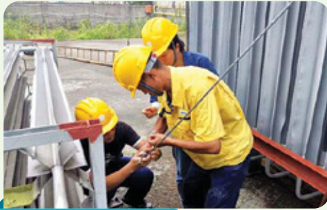
台州新奧員工冒雨搶修
