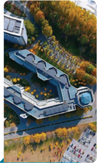
新奧能源太陽能板布設
